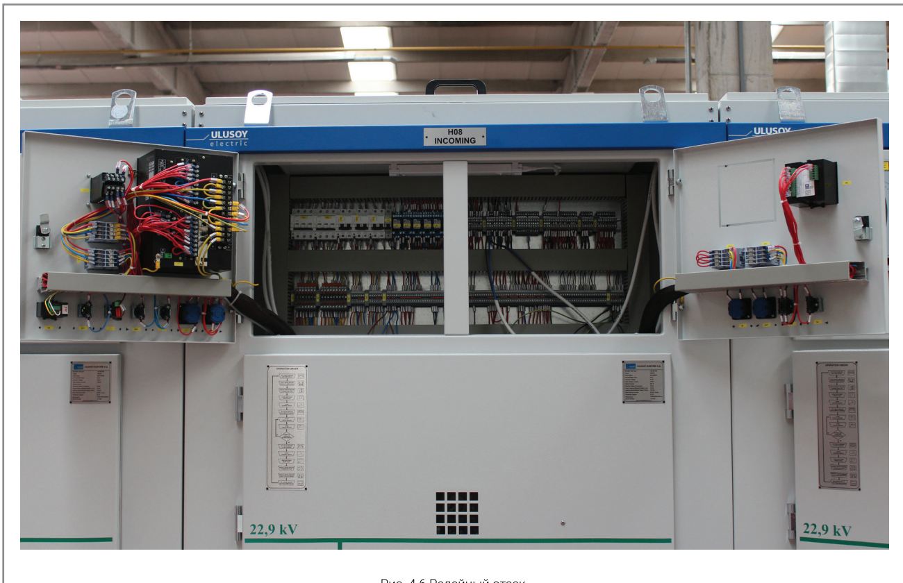
Рис. 4.6 Релейный отсек.
