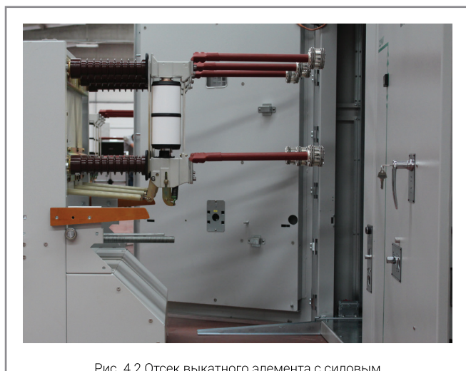
Рис. 4.2 Отсек выкатного элемента с силовым выключателем в контрольном положении
